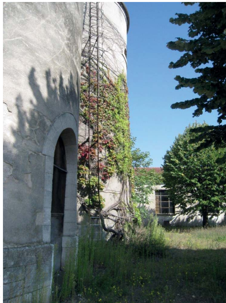
Photos vues depuis les réservoirs
