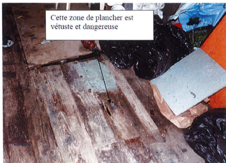
Photo n°3 - Intérieur –vue détaillée sur les désordres du plancher (rapport d'expertise du 17 mai 2024)
