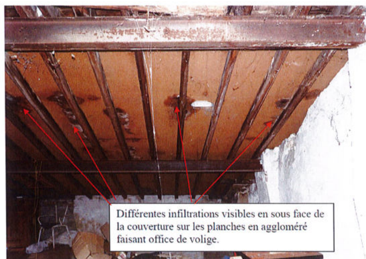
Photo n°4 - intérieur – vue détaillée sur les désordres sous toiture (rapport d'expertise du 17 mai 2024)
